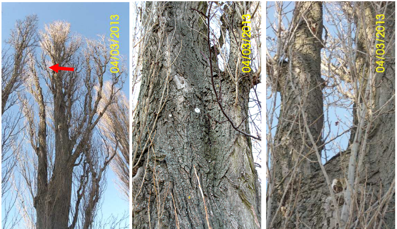
Abb.6a-c: Ansicht der Säulen-Pappel Nr.87 mit einer noch vitalen Krone mit etwas Totholz (Pfeil) sowie stabil wirkenden Starkastgabelungen und kräftigem Stammholz mit normaler Einwölbung ohne Kerbrissbildung.
